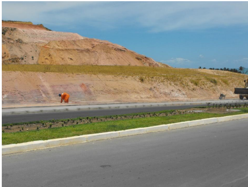
Corte na Formação Barreiras, solos arenosos na parte superior e com tendência à laterização na parte inferior. Foto de Referência na Av. Josefa de Mello.
