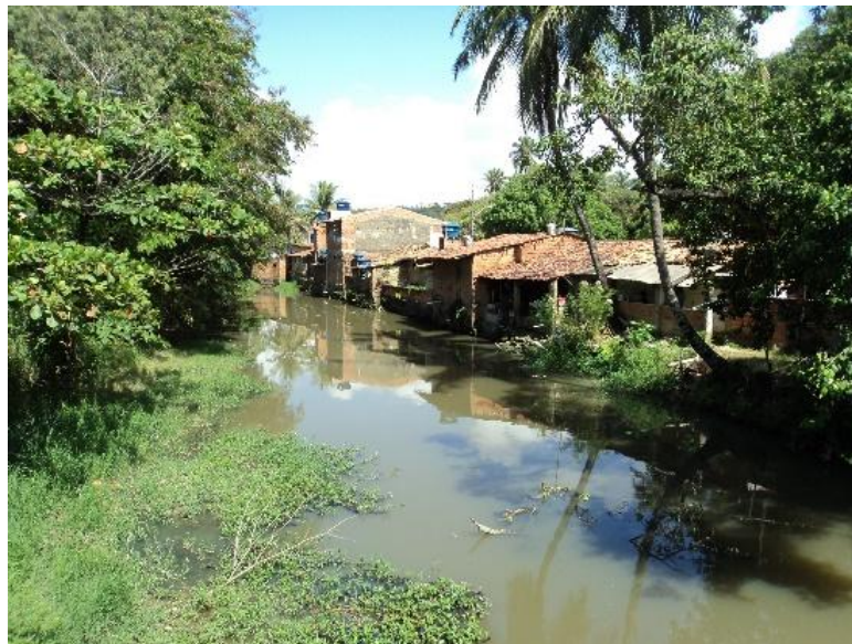
Ao passar na ponte sobre o rio Jacarecica, percebe-se a área de APP desse corpo hídrico invadida por precárias moradias em áreas de situação de risco. Foto Green.
