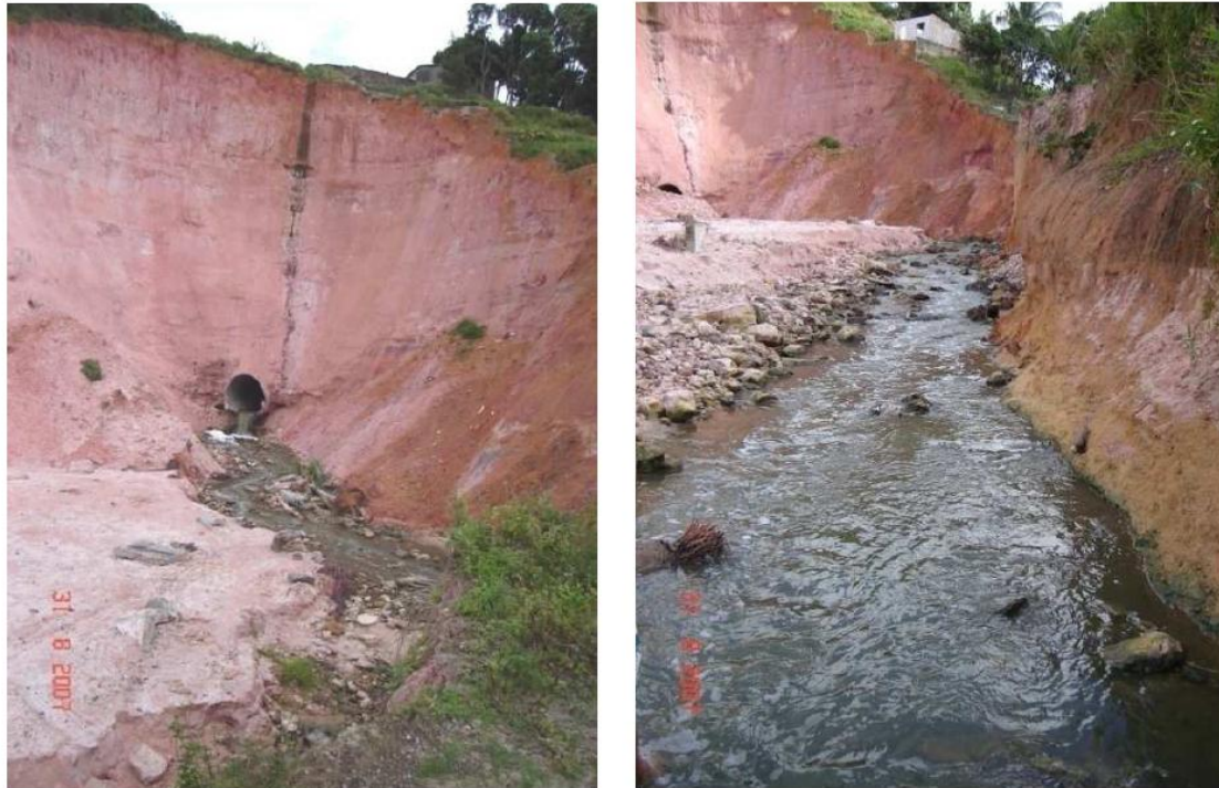
Ponto de Lançamento do sistema de macrodrenagem do Tabuleiro dos Martins
