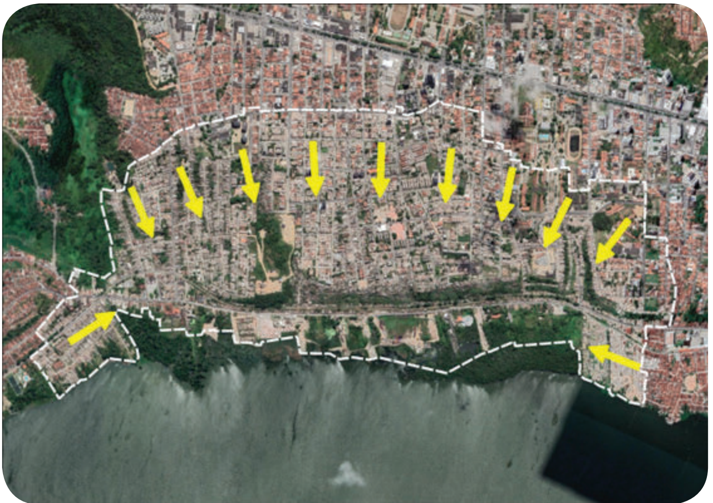
Figura 3 – Direção das atividades de demolição
