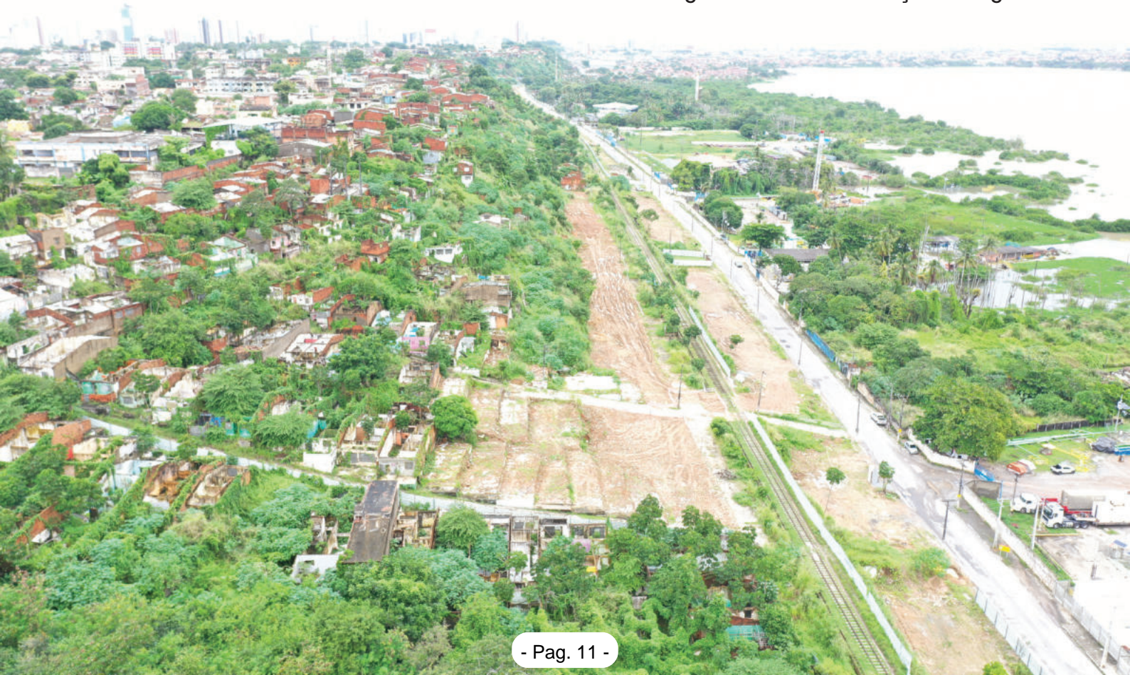
Vista da encosta do Mutange onde houve demolição emergencial
