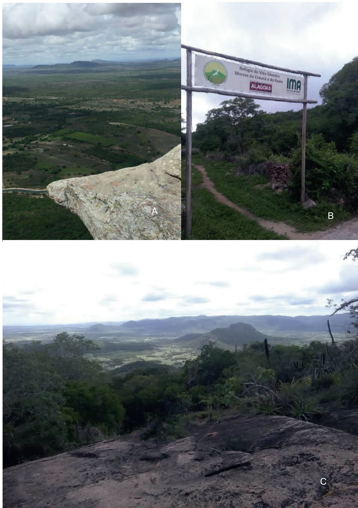
Fig.2: A: Vista do topo do Morro Craunã; B: Entrada na trilha; C: Vista da metade do morro. Fotos: M.C.S.Esteves.
