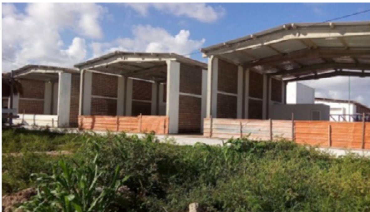
Foto 3: Estaleiros construídos no Centro Pesqueiro
