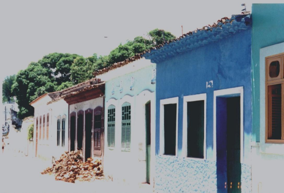
Rua Tavares Bastos – Antigo bairro nobre de Marechal Deodoro
