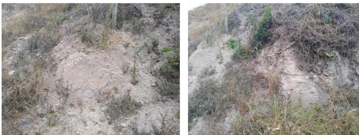
Figura 5.16 – Vista de uma exposição típica dos quartzitos micáceos do Complexo Arapiraca em corte de estrada de acesso à margem do Rio Branco na ombreira direita do eixo da barragem.
