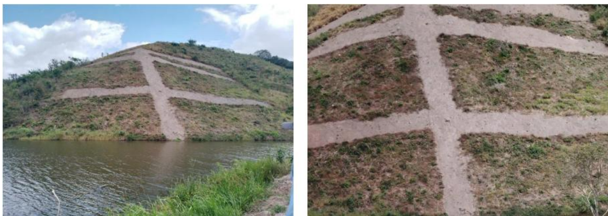
Figura 5.18 - Vista da ombreira esquerda do eixo barrável, com vale inundado pelas águas da bacia hidráulica de barragem existente a jusante e detalhe da forma de ocorrência dos quartzitos na vertente da ombreira esquerda do eixo barrável.
