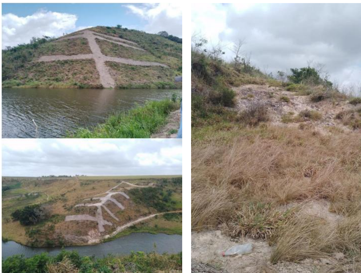
Figura 5.9 - Paisagem associada aos quartzitos do Complexo Arapiraca no local do local do barramento. Acima, ombreira da margem esquerda e abaixo ombreira da margem direita.
